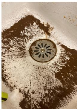
**Le désembouage hydrodynamique fait exclusivement appel à un mélange d'eau et d'air pulsé, créant des mini ondes de chocs qui en se propageant dans le système de chauffage permettent de décoller les particules adhérentes qui sont éliminées ensuite par rinçage du circuit d'eau.**
